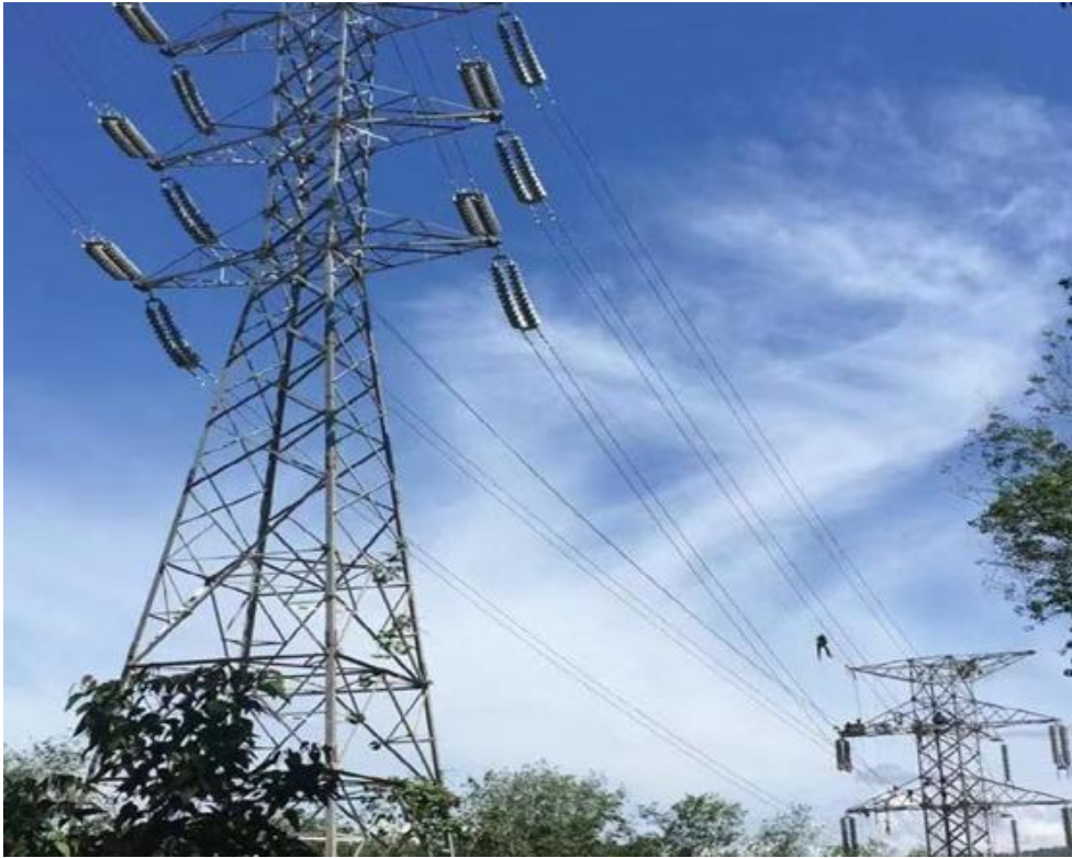
150kv 输电线路架线施工中
